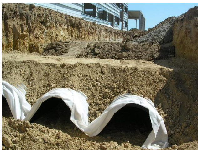
Obr. 8. Vrtné jádro z kaolinických pískovců a vsakovací tunely místně v těchto pískovcích
