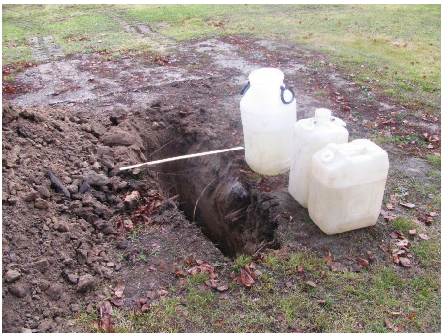
Obr. 3. Realizace vsakovací zkoušky v kopané sondě
